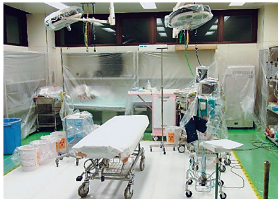
現在の被ばく医療棟処置室
